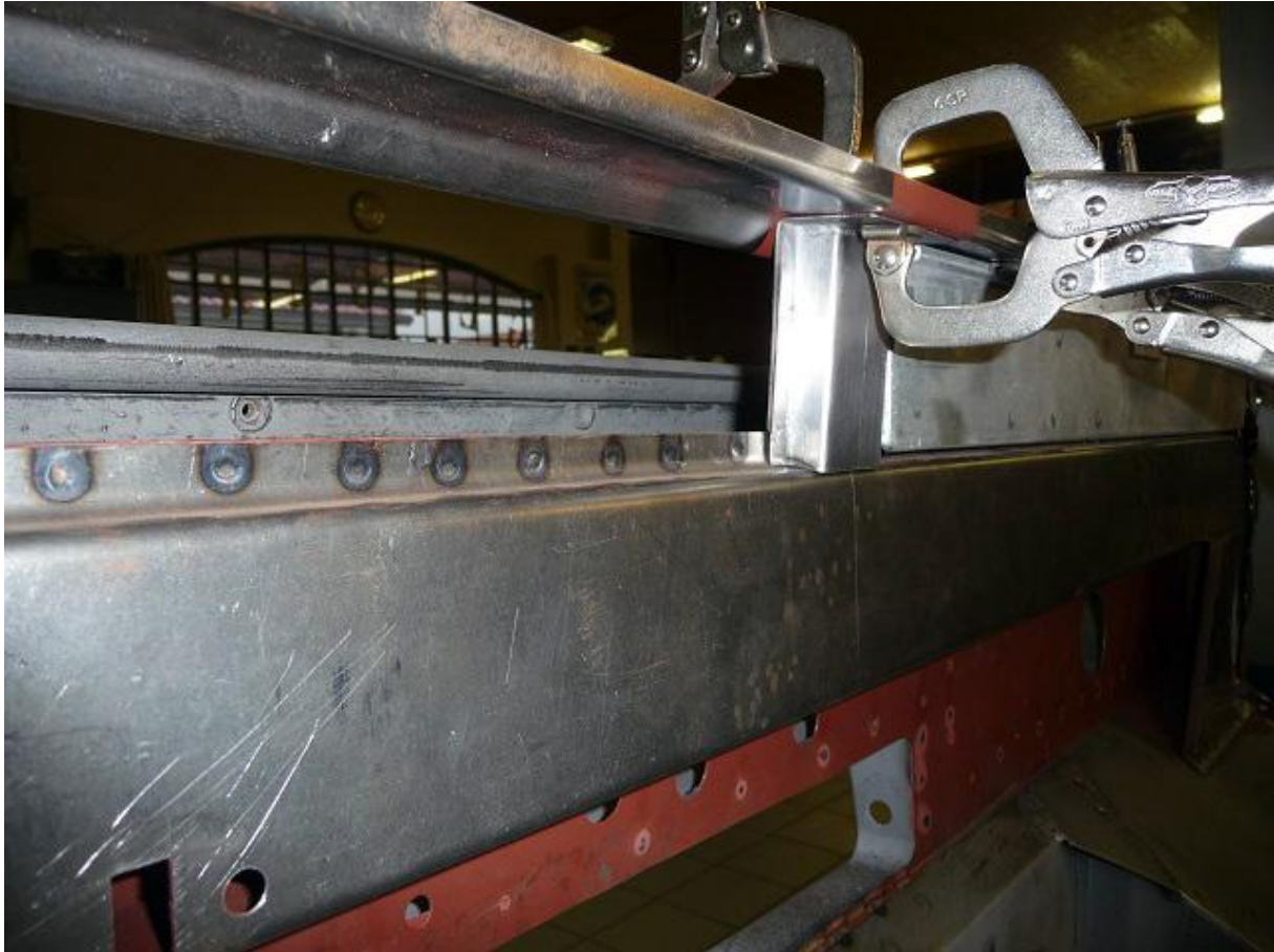
Während den Schweißarbeiten an der Spritzwand.
